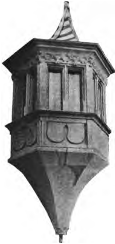
Fig. 194. Spätgotischer Erker in Zug mit vier Schilden an den Wangen.
